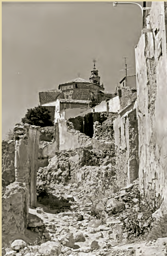
Vista de casas derruidas por la explosión del Polvorín.
